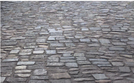
Das historische Pflaster ist im Polygonalverband verlegt
